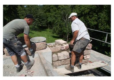
Die Arbeiten der Friedhofsanierung kommen gut voran. Die seitliche Stützmauer wurde neu aufgebaut und ist zum Teil schon mit Sandsteinen verblendet. Dier ersten Fundmente für die Grabreihen wurden auch schon betoniert. In den nächsten Wochen werden die ersten Grabsteine wieder aufgestellt.
